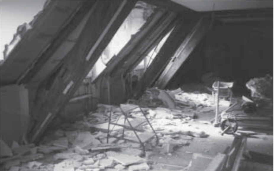
So sahen unsere Büroräume im Dachgeschoss nach wenigen Umbautagen aus.
